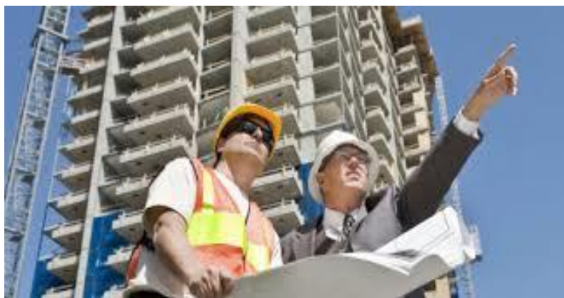
Construção de Edifícios (Tipo III)
